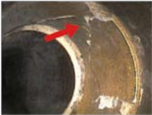
Riss im Anschluss
