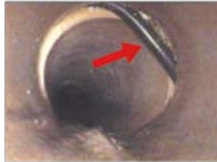
einragende Dichtung
