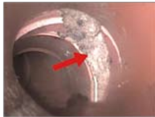
verschobene Rohrverbindung
